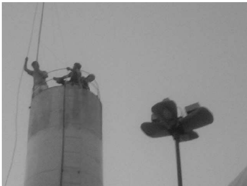
Imagem 1: Instalação da antena da rádio Voz da Ilha na Escola. Fonte: Fonseca (2015, p. 25).
