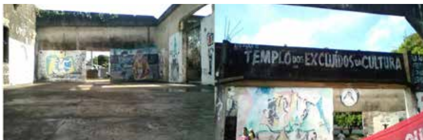
Figura 1: Ruínas da Casa da Cultura
